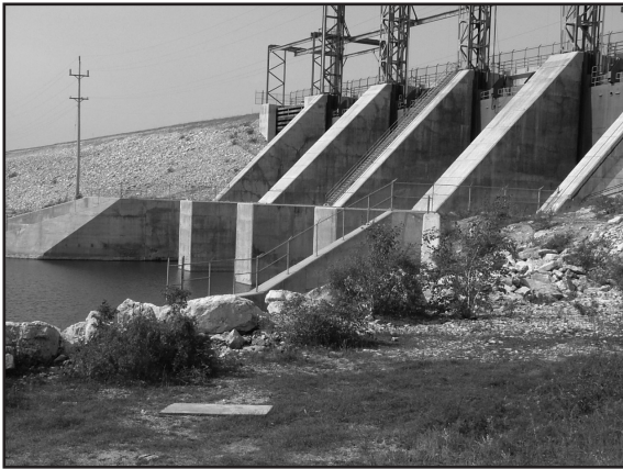
The spillway dam.
