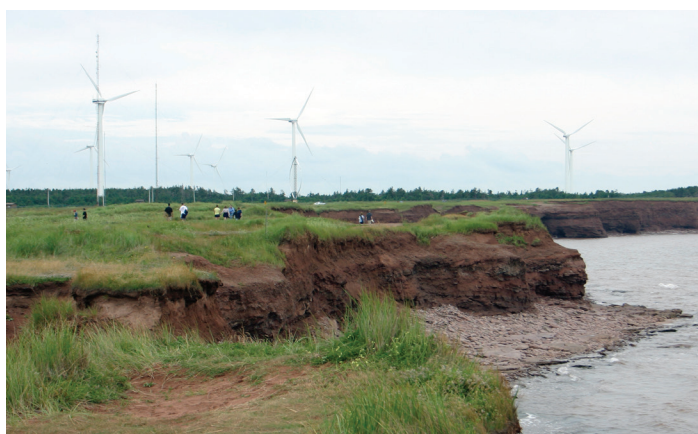
L'Institut de l'énergie éolienne du Canada, situé à l'extrémité nord-ouest de l'Île-du-Prince-Édouard, mène des recherches sur l'énergie éolienne depuis 1981.
